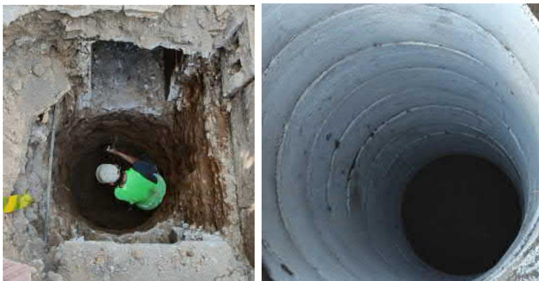
Gambar 3.2.7.7 Pekerjaan SPAH terintegrasi SAH di Panembahan Kraton
