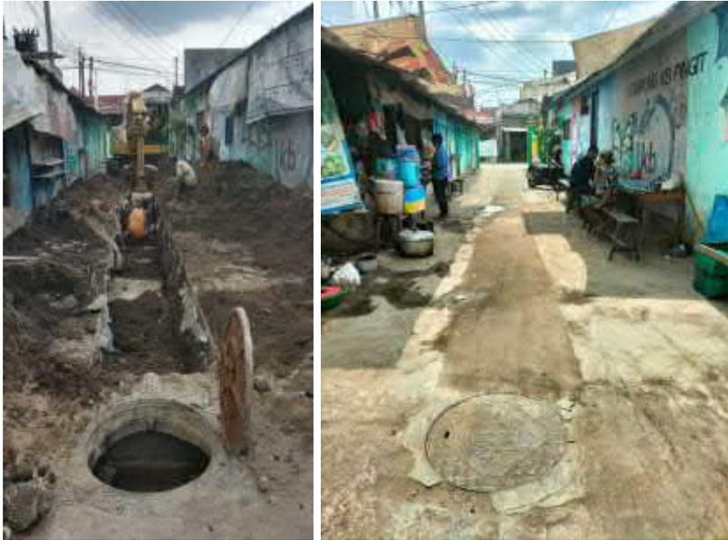
Gambar 3.2.7.27 Pemeliharaan SAL Insidentil (Perbaikan SAL Pingit)
