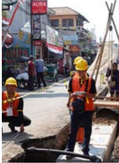
▶ Pelatihan dan Uji Sertifikasi Pelaksana Lapangan Pekerjaan Drainase
