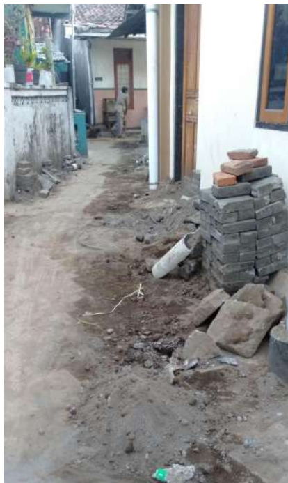
Gambar 4.129 Kondisi Pembangunan Saluran Pembawa dan Sambungan Rumah
