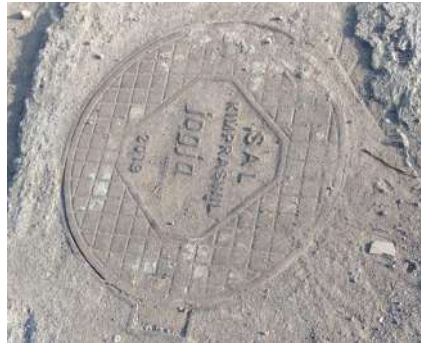
Gambar 4.128 Kondisi Fasilitas Saluran Air Limbah
