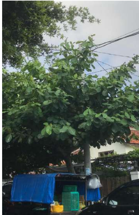
Gambar 4.150. Gangguan Penerangan Jalan Umum yang Tertutup Pohon
