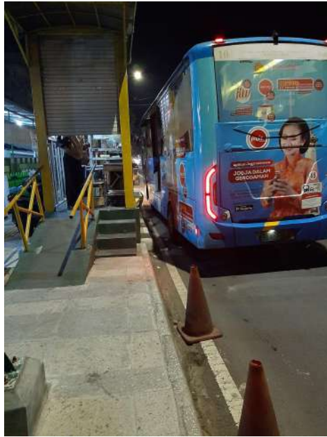
Gambar 4.3 Kondisi Halte Trans Jogja yang Masih Layak
