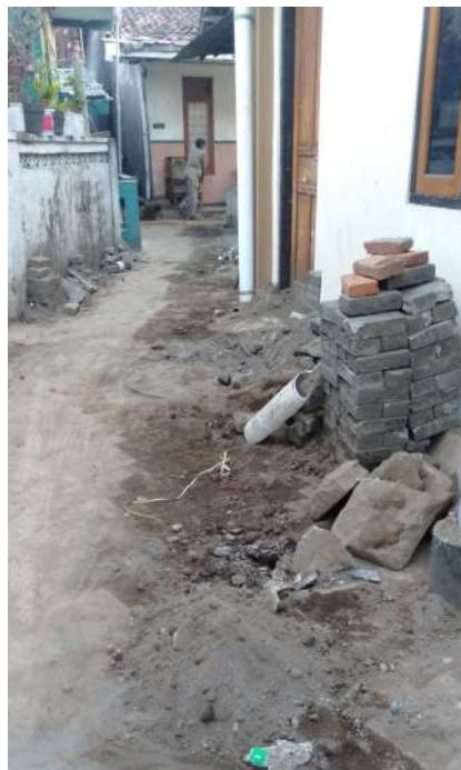
Gambar 4.129 Kondisi Pembangunan Saluran Pembawa dan Sambungan Rumah
